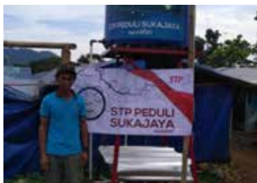
Instalasi air bersih bantuan bencana longsor di Sukajaya, Bogor
